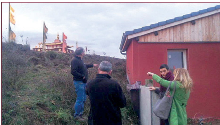
Ermitage : discussion de chantier pour l'accessibilité au public
